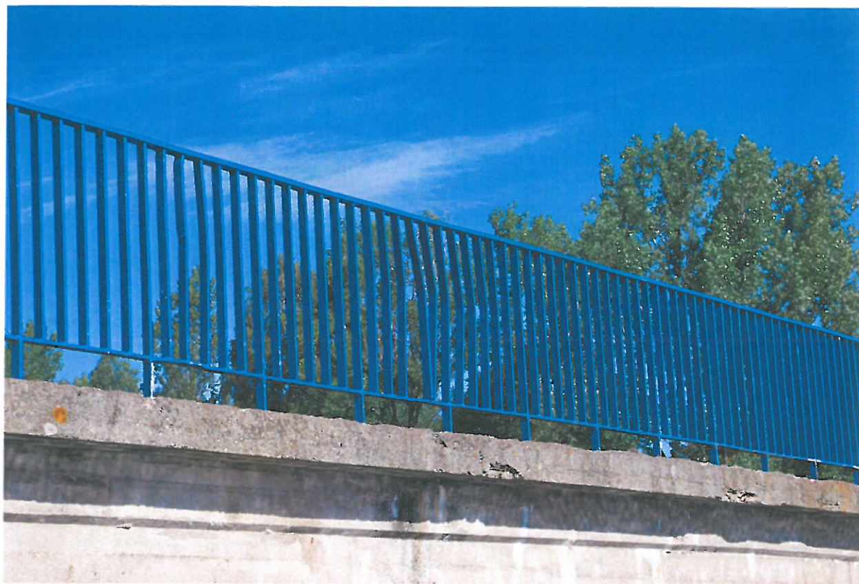
Fot. 9. Deformacja szczeliny
