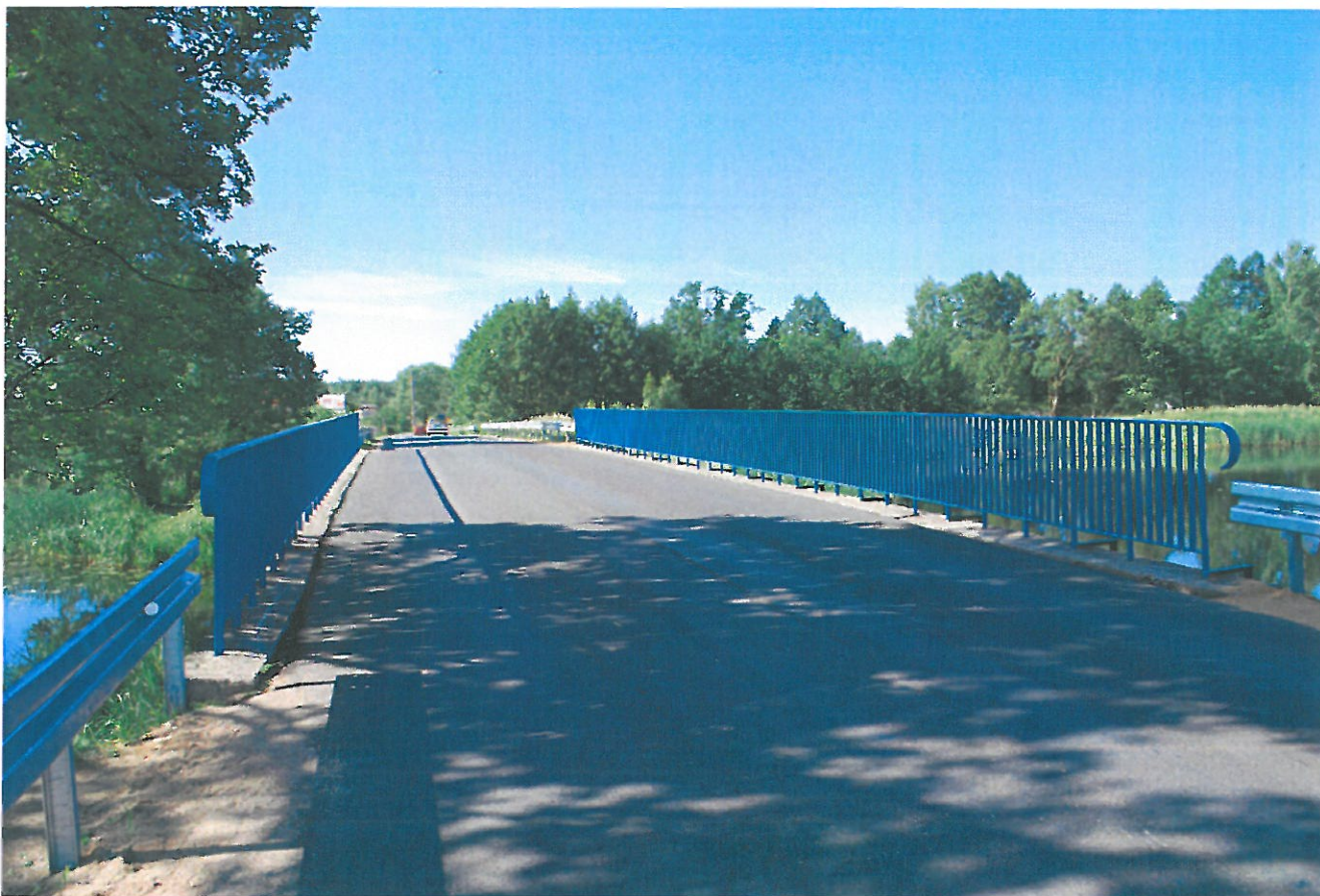
Widok ogólny mostu
