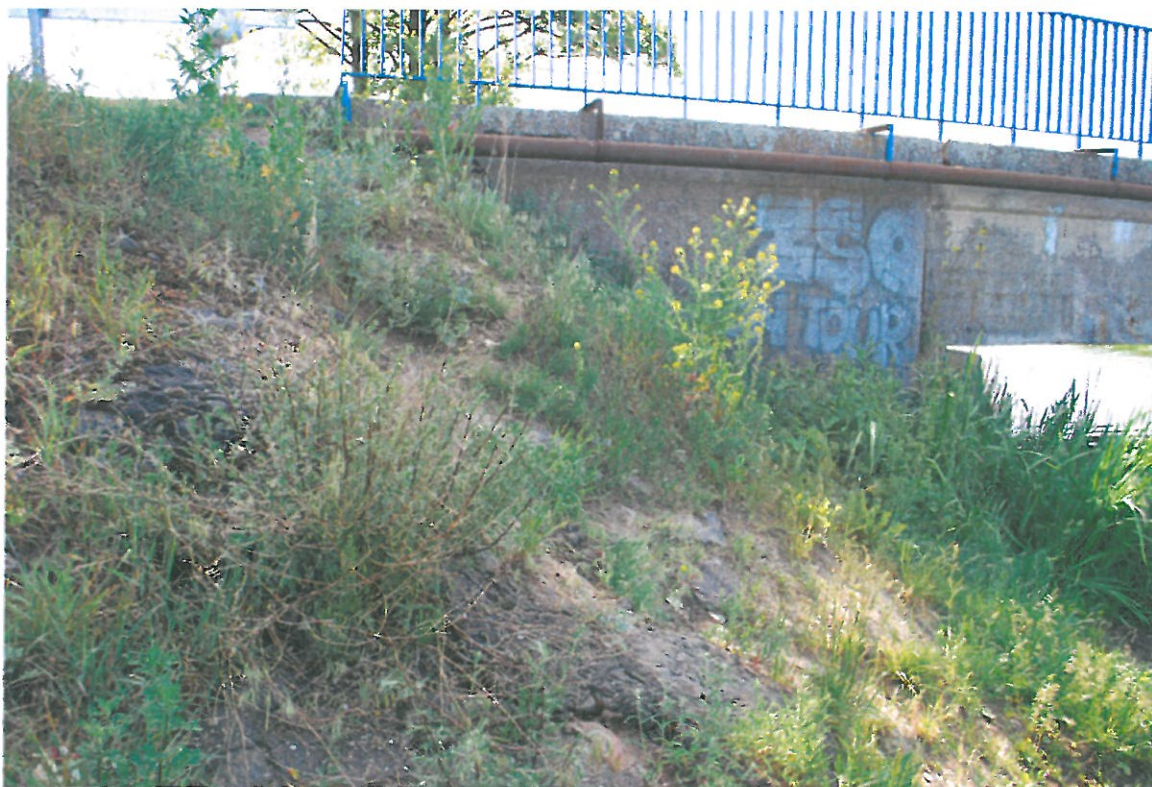
Fot. 6. Wegetacja roślin oraz zanieczyszczenia pogarszające estetykę stożka spowodowana brakiem systematycznych prac utrzymaniowych (stożek od strony północnej – widok od strony dolnej wody)
