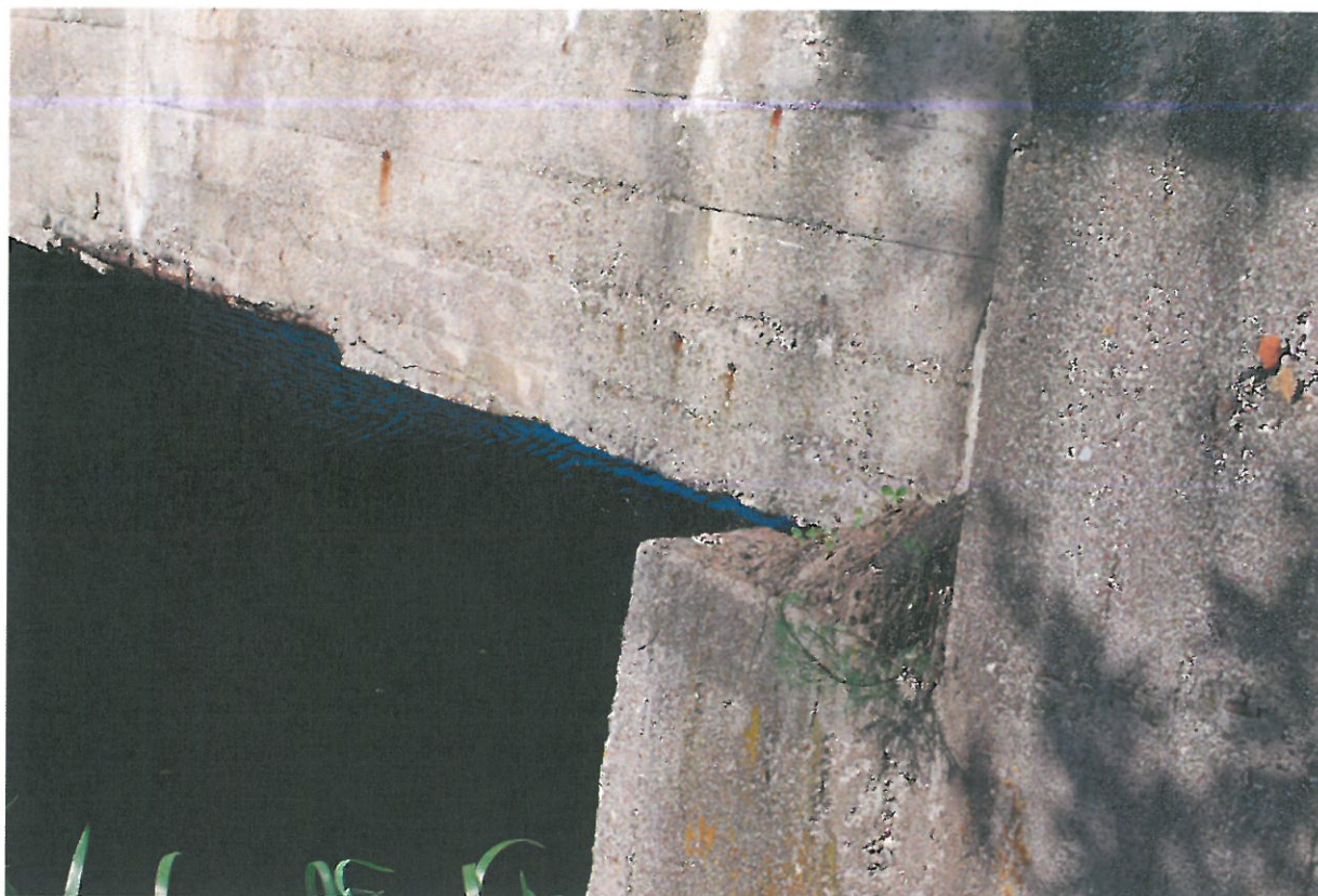
Fot. 15. Wegetacja roślin, zanieczyszczenia, osady i wykwyty przyczółka północnego – od strony górnej wody
